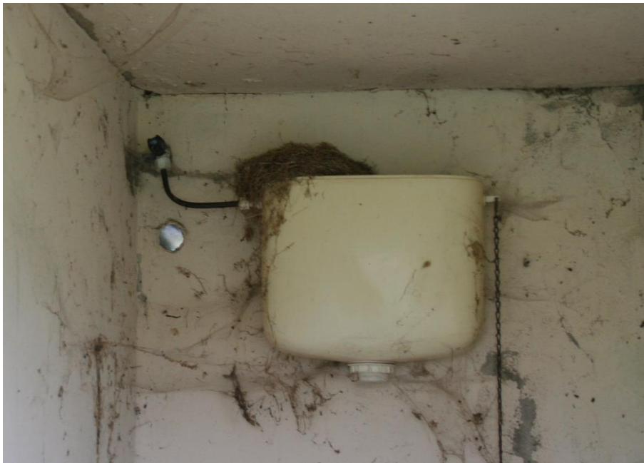
Abb. 3: Vogelnest eines Nischenbrüters im Toilettenhäuschen im Vorhabengebiet (eigene Aufnahme 14.03.2024).
